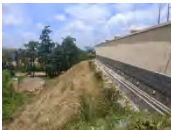
升压站外边坡绿化
