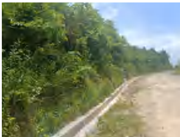
一般边坡防护及排水设施现状
