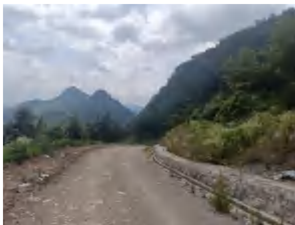
道路拦挡及排水设施
