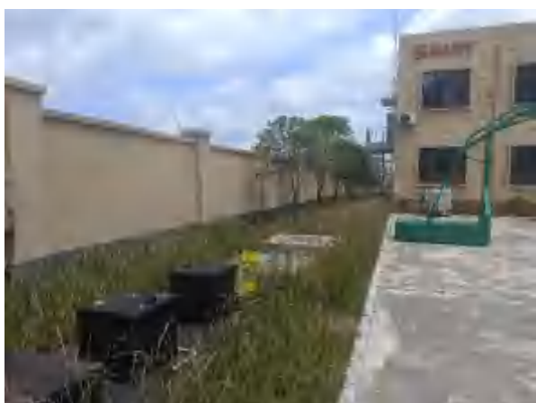
升压站内绿化
