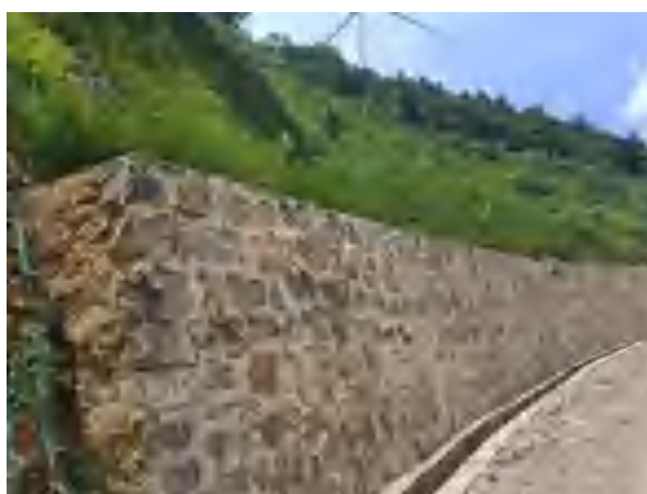
边坡拦挡防护及排水设施现状
