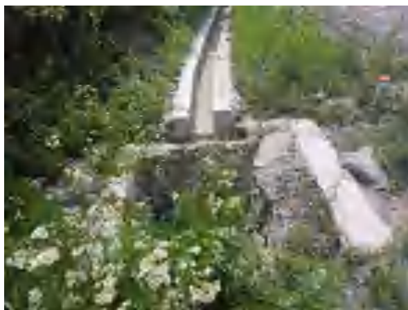
浆砌石砼沉沙池
