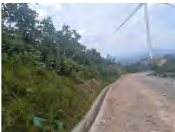
边坡防护及排水设施现状
