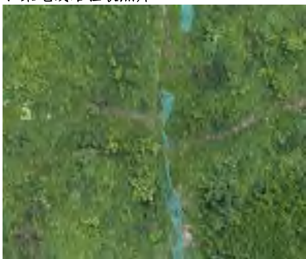
直埋电缆现状
