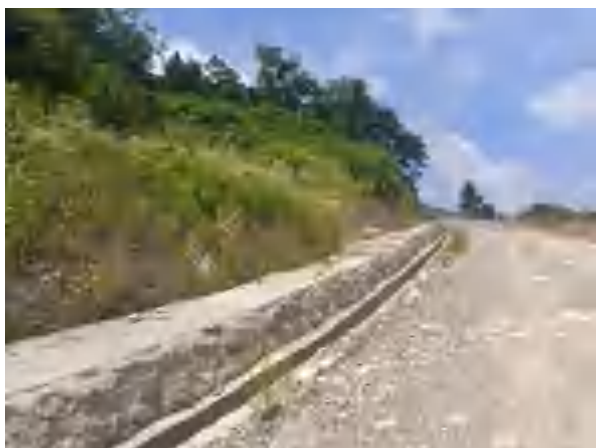
道路拦挡及排水设施
