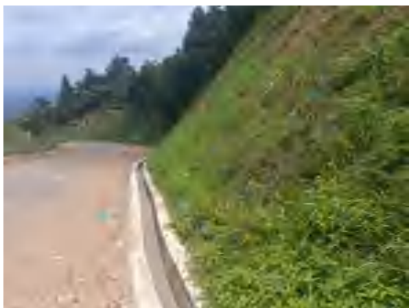
高边坡防护及排水设施现状
