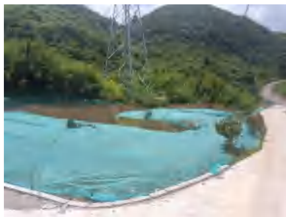
施工生产区全貌
