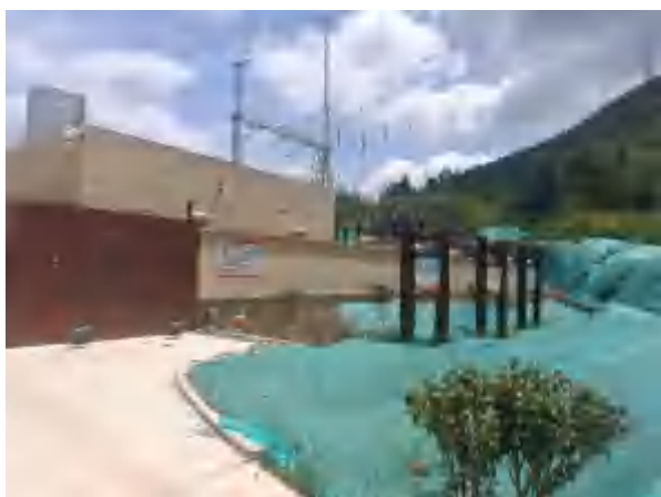
施工生产区（紧邻升压站南侧）
