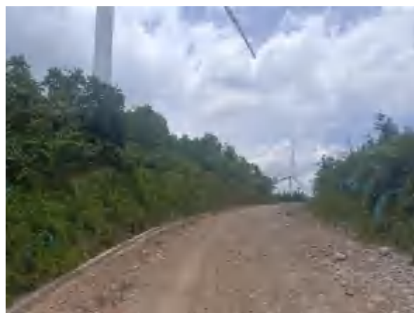
一般全挖道路现状
