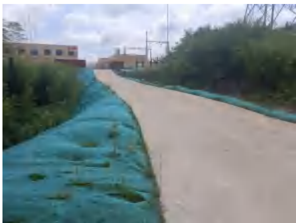
升压站道路现状
