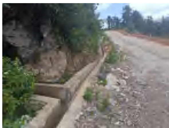
道路排水设施
