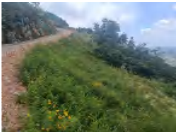
一般填方边坡植被恢复情况
