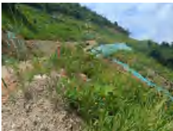
开挖边坡植被恢复
