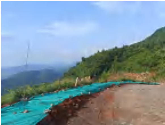
道路路肩植被恢复
