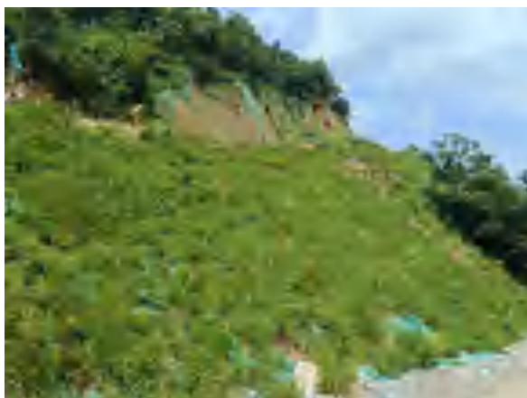
一般填方边坡植被恢复情况
