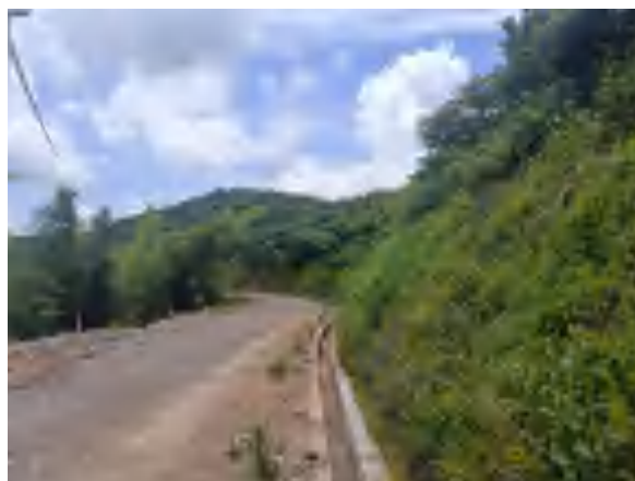
开挖边坡植被恢复
