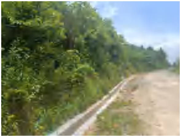
场内道路排水沟现状
