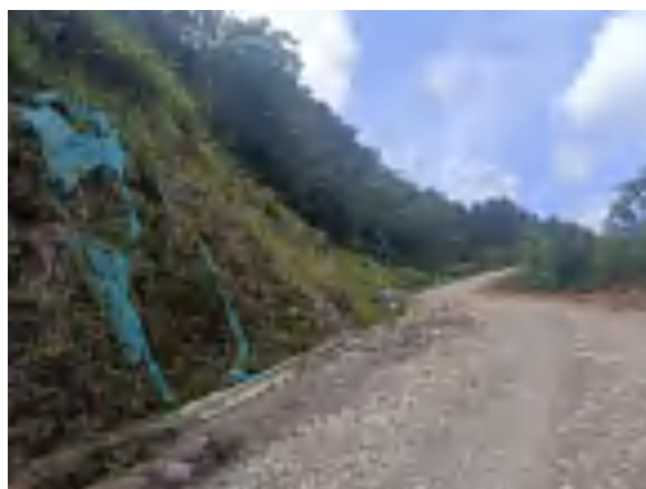
开挖边坡植被恢复
