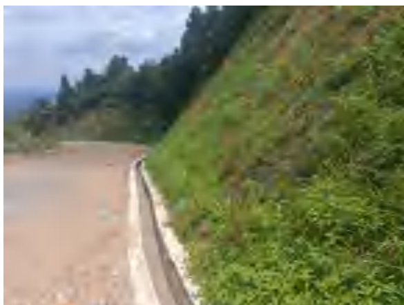
开挖边坡植被恢复
