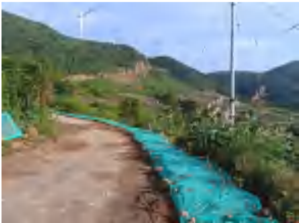
道路路肩植被恢复
