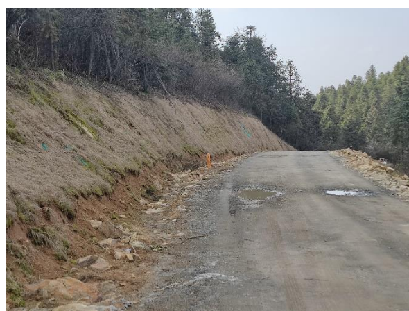
5~7#风机道路路基内侧临时排水沟
