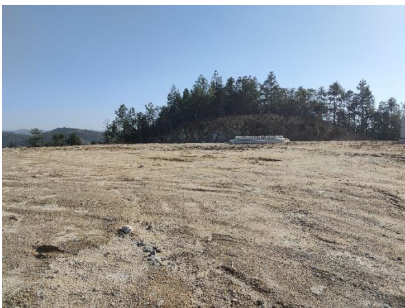
18#风机平台顶部及开挖边坡
