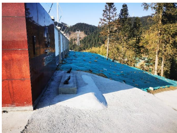
升压站站外边坡防护
