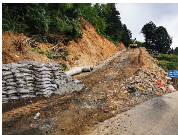
15~20#风机道路起点
