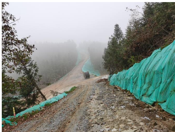
12#风机平台道路
