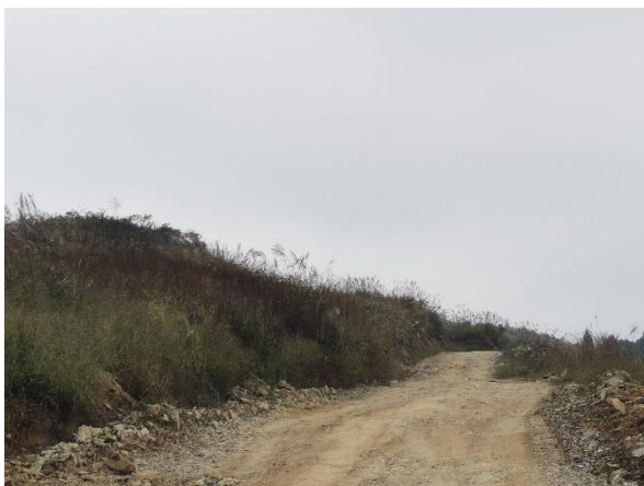
1#~3#风机道路起点
