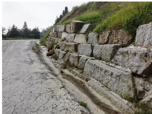
10#风机道路起点
