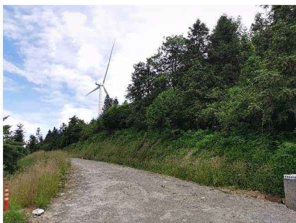
5~7#风机道路现状
