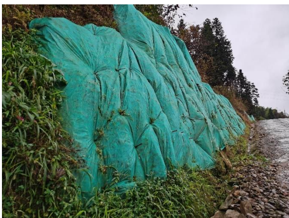
15-20#风机道路起点上边坡
