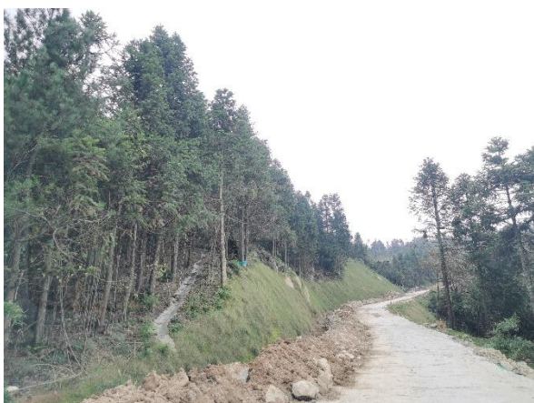
5#~7#风机道路坡面急流槽
