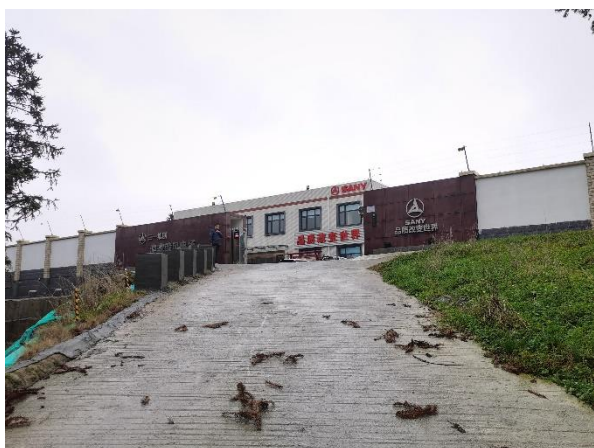
升压站站外防护
