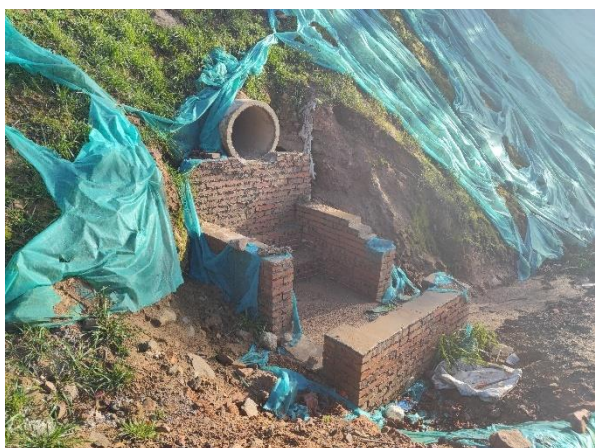
11#、13#风机道路路基排水涵管及坡面
