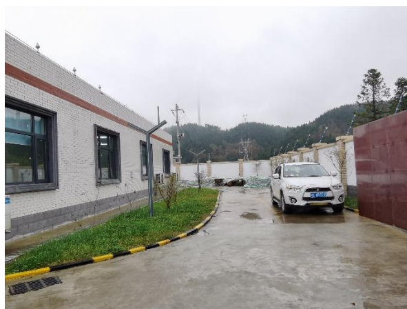
升压站排水绿化
