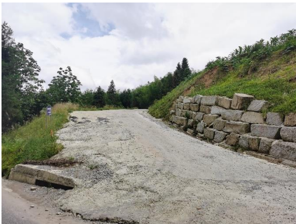
10#风机道路起点
