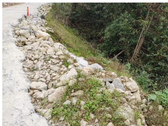
5~7#风机道路路面及挡水坎
