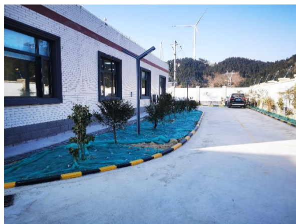
站内绿化措施
