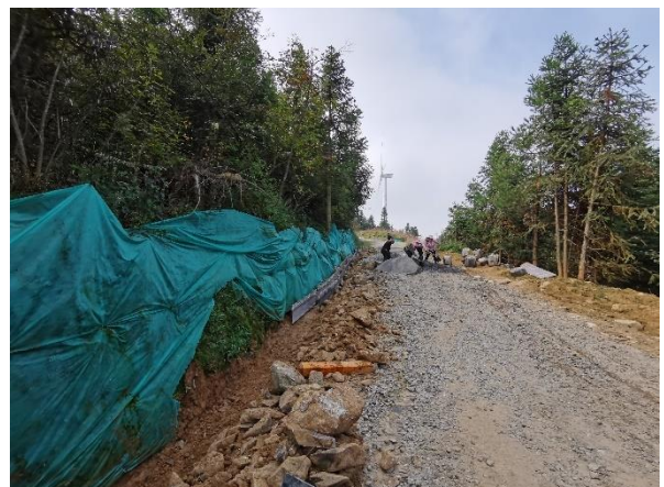
路基内侧砼排水沟施工
