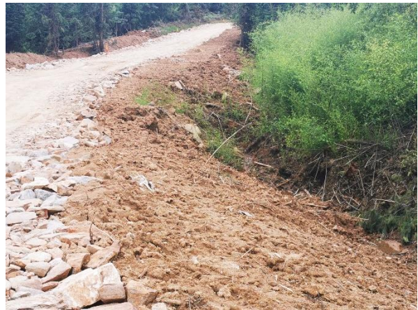
至 5#风机场内道路
