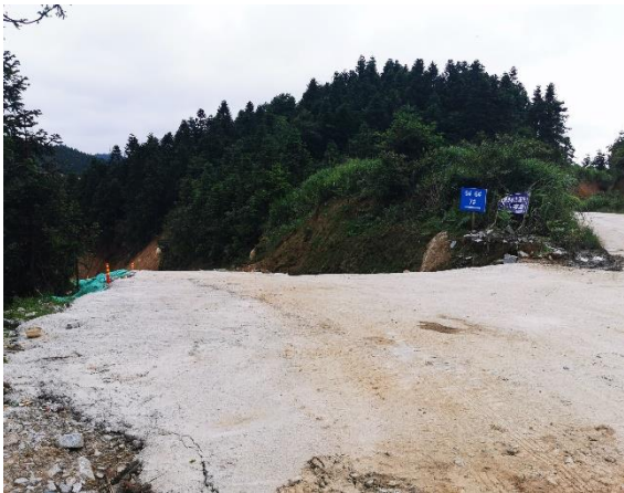
5~7#风机道路起点
