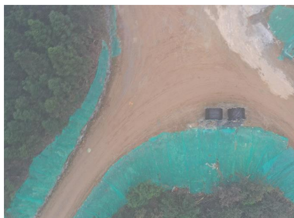
10~13#风机平台支路路口
