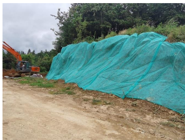
12#平台顶部开挖边坡
