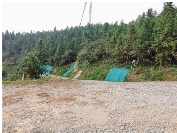
11、13#风机平台十字路口道路现状
