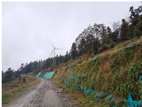
15-20#风机道路上边坡防护
