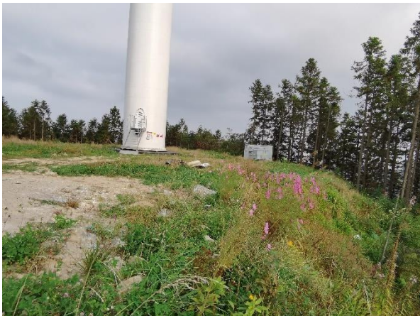
4#风机平台顶部及下边坡
