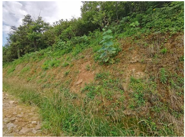
5~7#风机道路生态沟及上边坡
