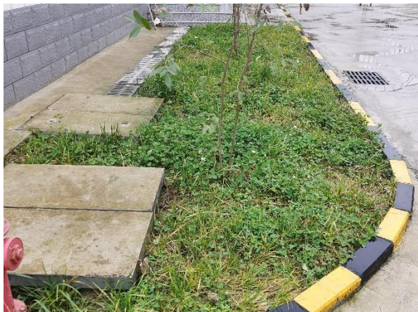
升压站排水绿化
