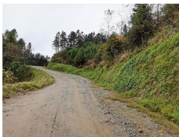
9~13#风机道路现状
