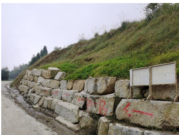
10#风机道路起点
