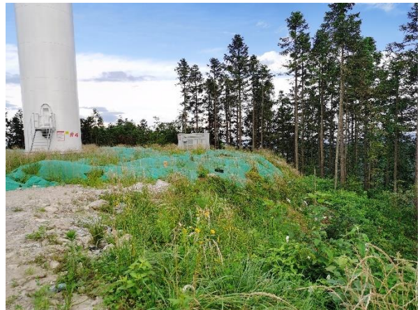
4#风机平台顶部及下边坡
