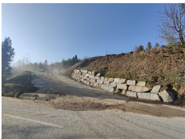
10#风机道路起点
