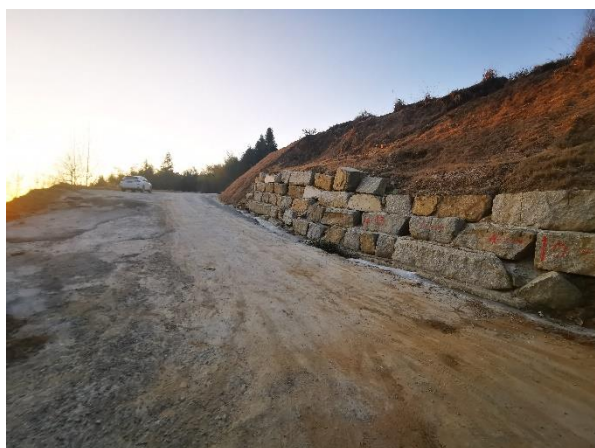
10#风机道路起点
