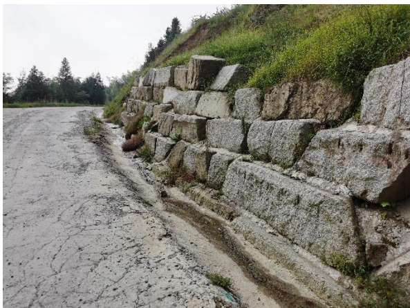
10#风机道路起点
