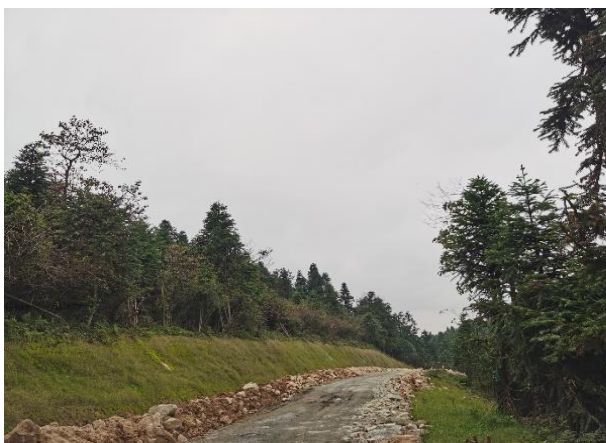
5#风机平台道路
