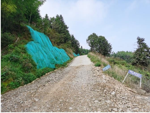
15~20#风机道路起点
