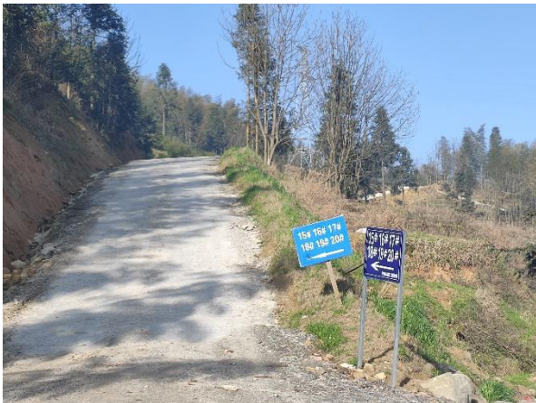
15~20#风机道路起点
