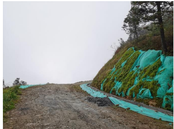
1#风机道路现状
