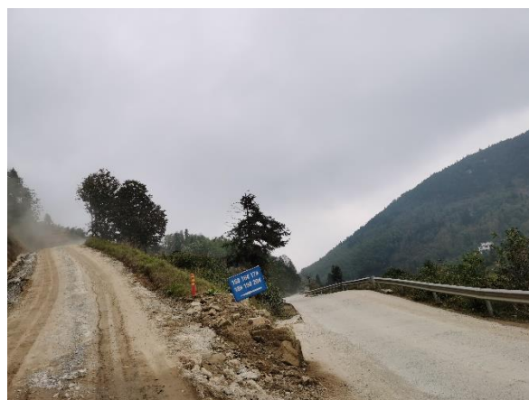
15~20#风机道路起点
