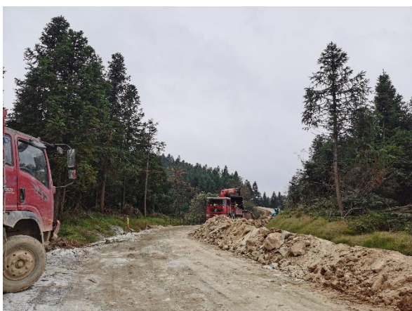
沿路集电线路施工
