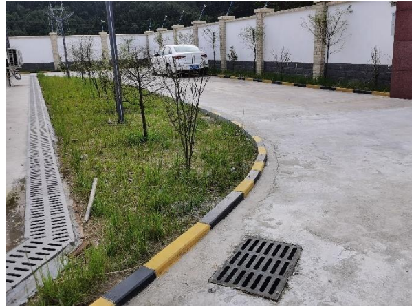
升压站内排水绿化
