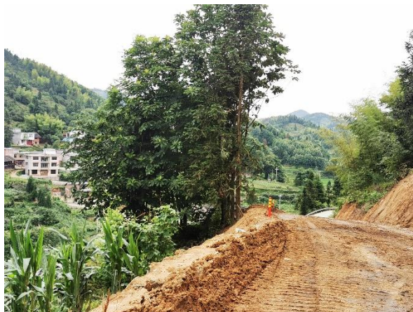
15~20#风机道路路肩
