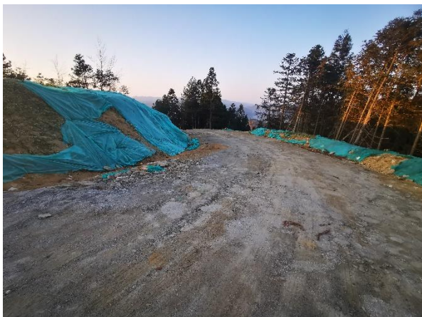
9#平台下边坡及道路路肩挡水坎
