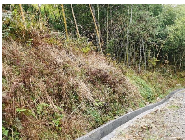
9~13#风机道路现状
