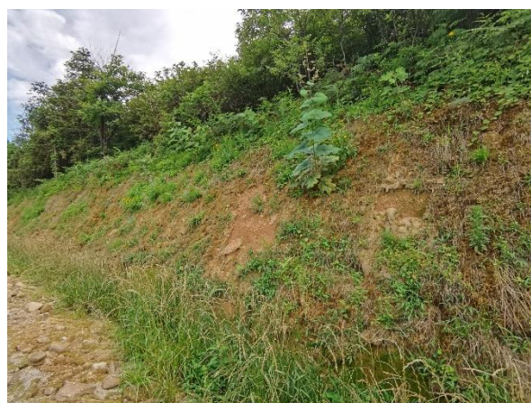
5~7#风机道路临时排水沟及上边坡
