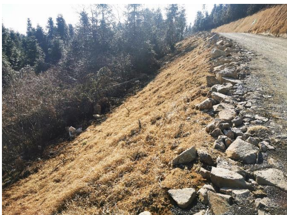
5~7#风机道路下边坡
