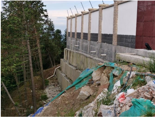
站外边坡防护
