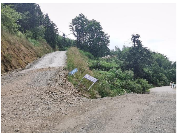
15~20#风机道路起点
