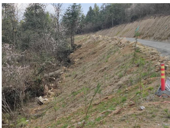
5~7#风机道路下边坡
