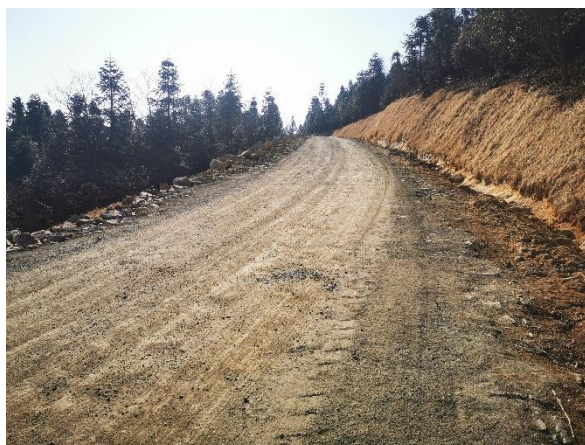
5~7#风机道路路基内侧临时排水沟
