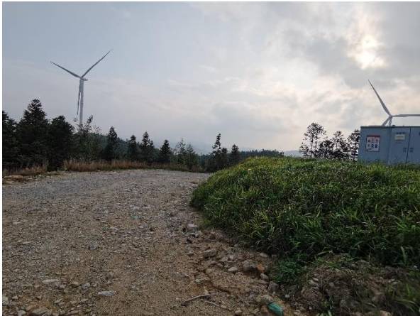
5#风机平台支线道路
