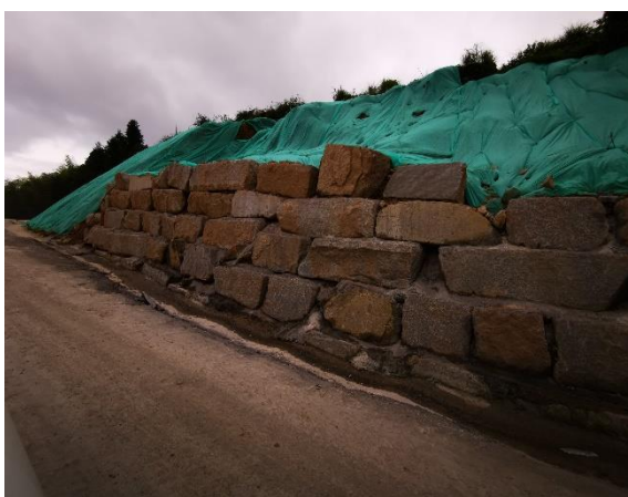
10#风机道路起点
