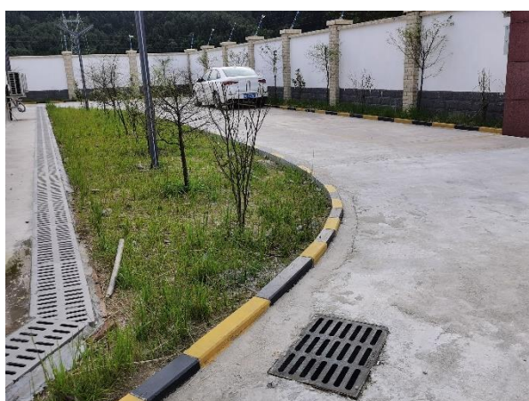
升压站排水绿化
