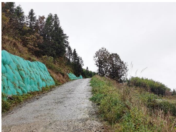
15-20#风机道路起点处
