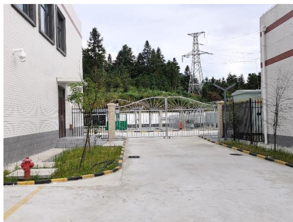
升压站排水绿化
