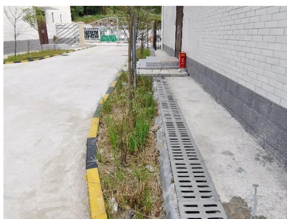
升压站排水绿化
