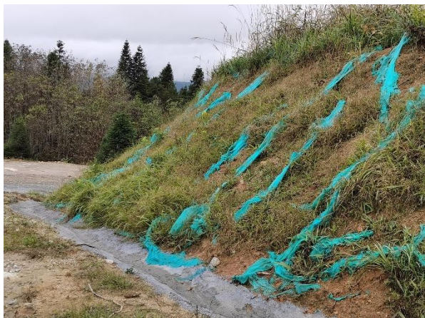
19#风机道路内侧抹面排水沟
