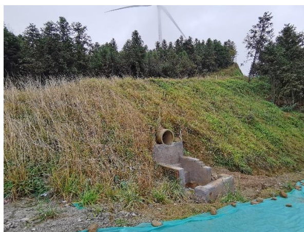
10#风机道路排水涵管、沉沙池
