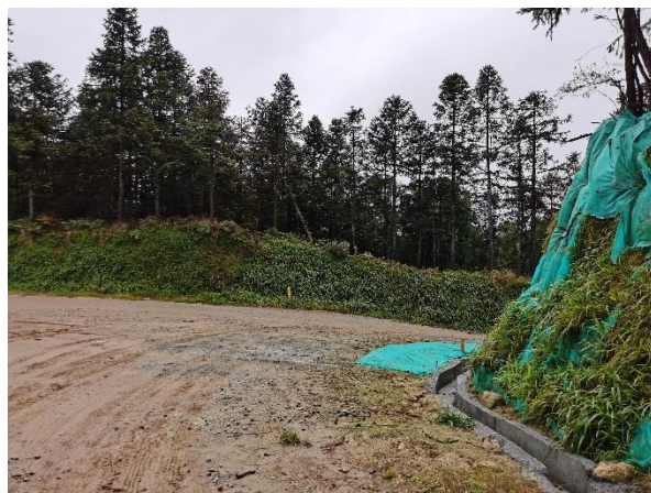
11#、13#风机道路路口现状
