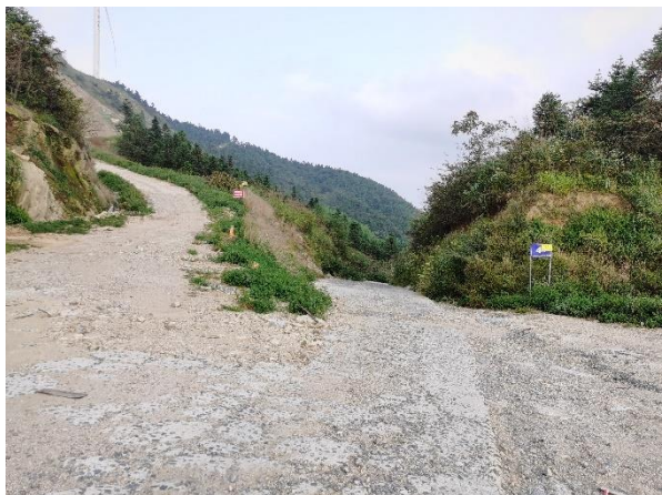
4#、8#风机交叉路口
