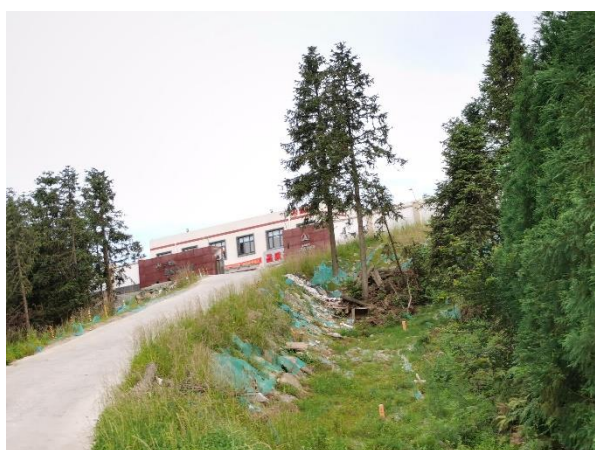
升压站站前防护
