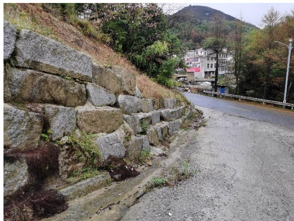
10#风机道路起点
