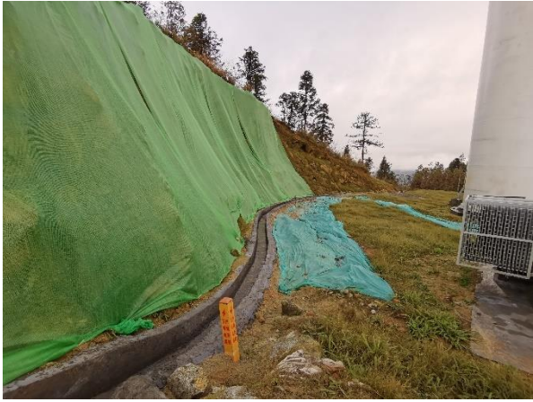
19#风机平台截水沟
