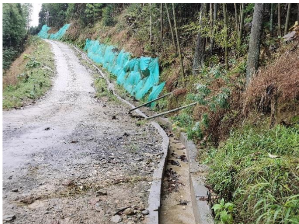
15~20#风机道路内侧排水沟
