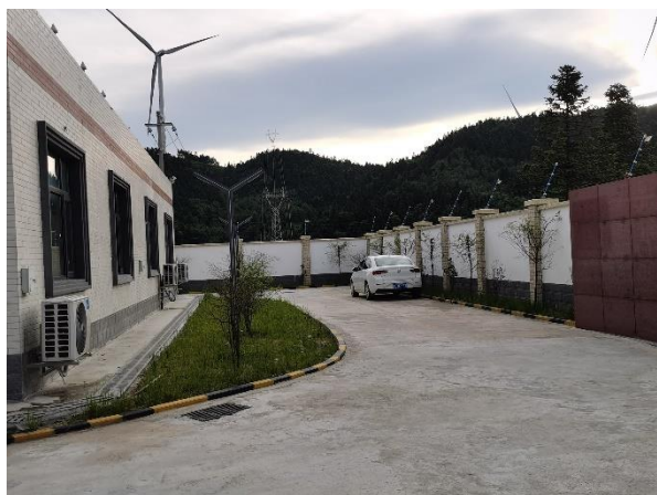
升压站排水绿化
