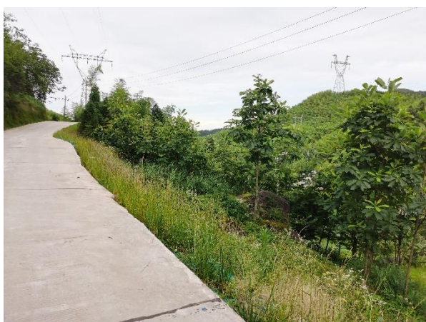
往升压站道路
