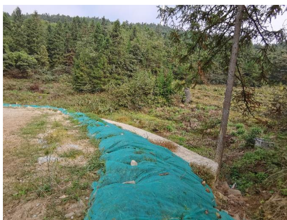
13#风机道路浆砌石挡墙
