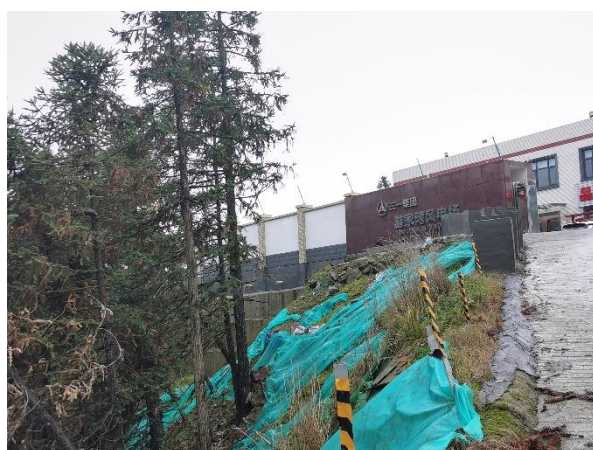
升压站站前防护
