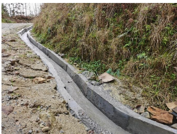
9~13#风机道路内侧排水沟
