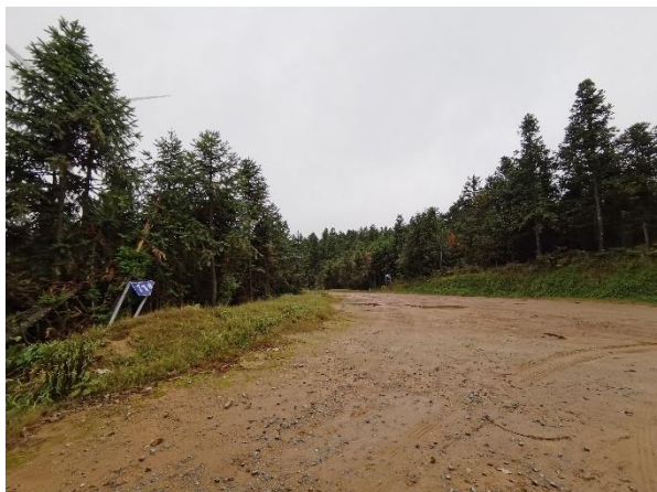
11#、13#风机道路路口现状
